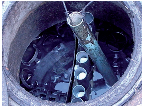
รูปที่ 2 ระบบบำบัดน้ำเสียที่มีการเติมตัวกลางยึดเกาะ
